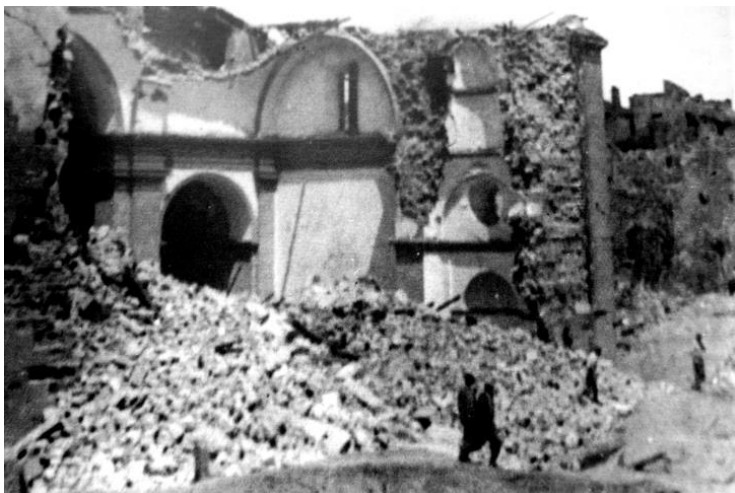
Fig. 2 - Il muro nord di S. Maria delle Fortezze risparmiato dalle bombe del 1944 che, come il simmetrico sud, sarà abbattuto con una ordinanza del sindaco nel 1949.
